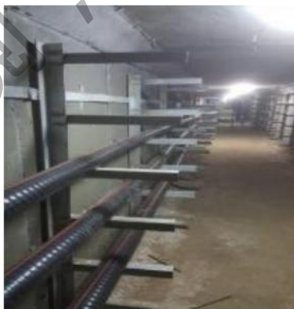
电缆隧道中，光缆安装在电缆表面
